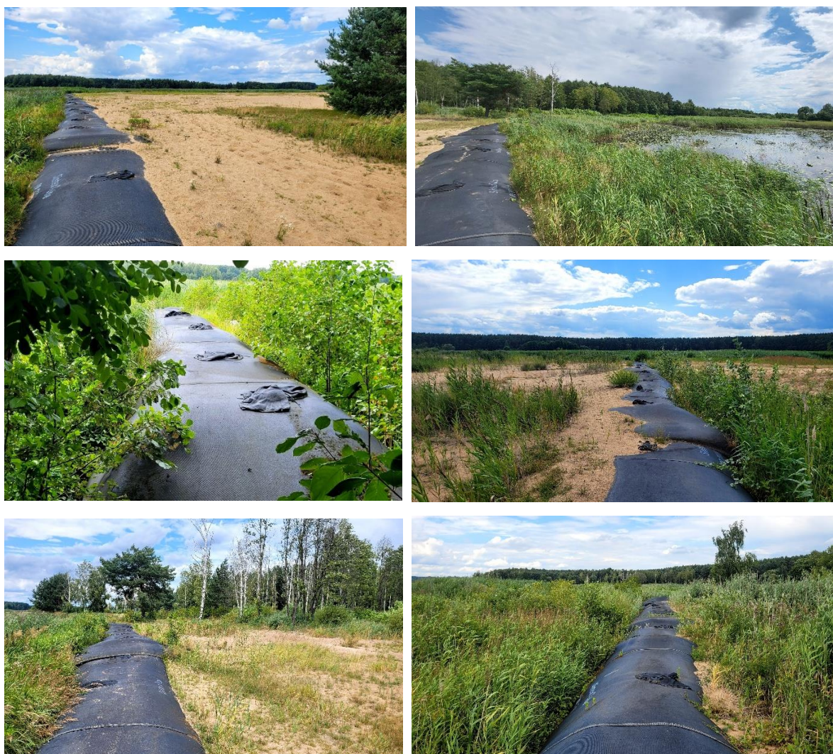
Fot. 78 Sulejów-Podklasztorze. Geotuby wypełnione piaskami i żwirami z refulacji, zabezpieczające powierzchnie, na których zdeponowano materiał z udroźniania koryta Pilicy (Fot. S. Krysiak 2025)
