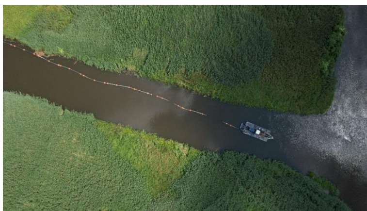
Fot. 75 Refulator w trakcie prac nad pogłębianiem odnogi Pilicy (Fot. M. Adamiak maj 2022)
