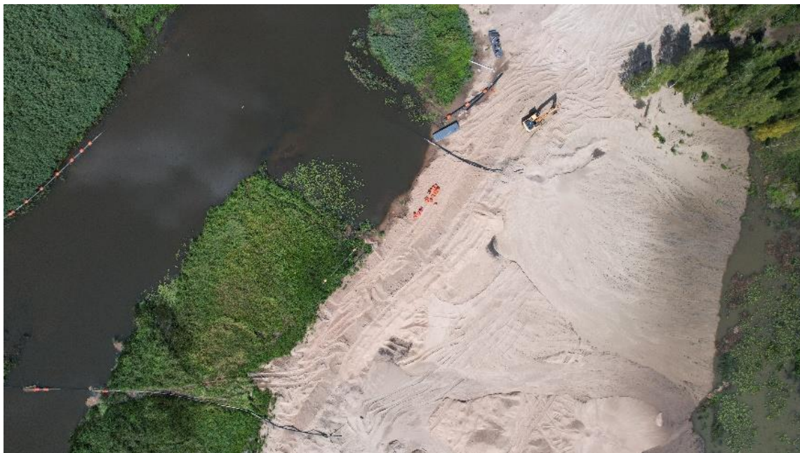
Fot. 76 Składowanie i wyrównywanie materiału z pulpy refulacyjnej w pobliżu północnego krańca wału przeciwpowodziowego (Fot. M. Adamiak maj 2022)
