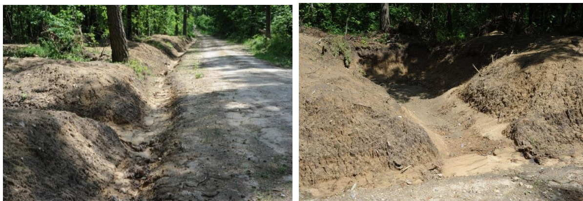
Fot. 58 Zabezpieczenia przeciwoerozyjne drogi leśnej na stoku Czartorii (Fot. S. Krysiak 2019)
