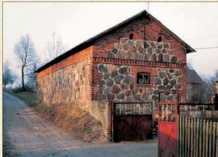
Przykład wykorzystania głazów narzutowych w tradycyjnej architekturze na terenie parku fot. K.K.
